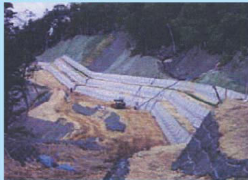
② 薄別川治山工事
