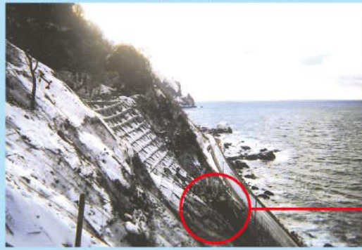
① 岩内町カストンネル工事(国道229号線)
