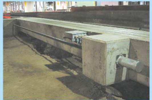
③ 南基地庫外軌道桁補強工事
