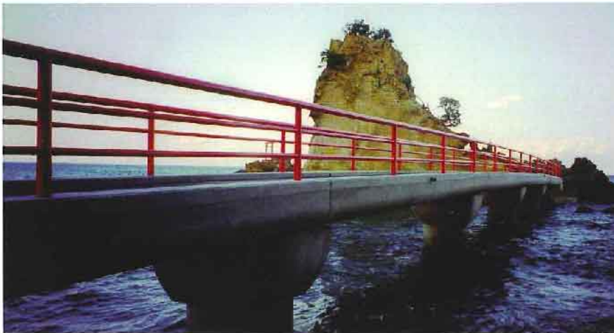
いわき市の波立海岸にある弁天橋は、上部構造（RC中空床版橋）および下部構造のすべてのコンクリート補強材として、FRP補強材が使用されています。
