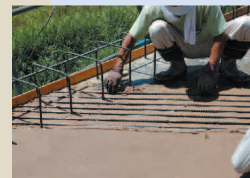
リードライン補強工事状況
