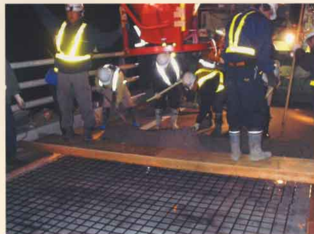
ネフマック鋼床版設置状況
