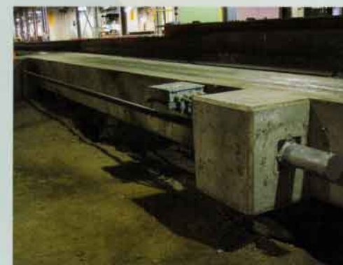
外ケーブル補強完了
