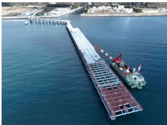
写真-3 床版据付状況遠景
