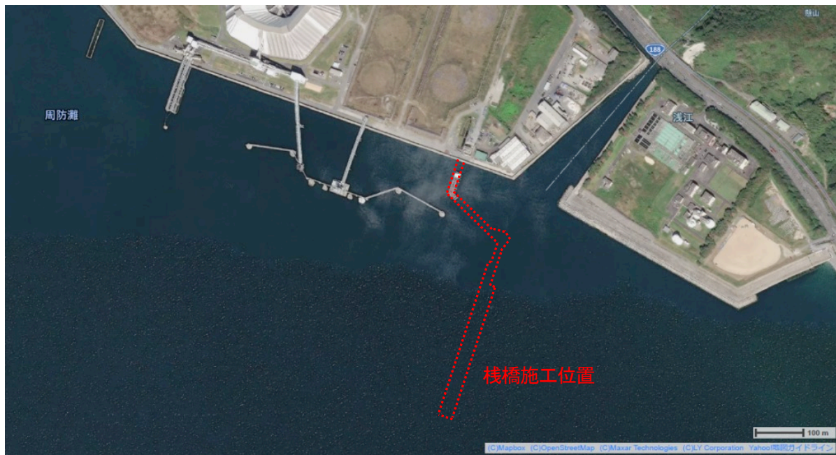
写真-5 徳山下松港下松地区(航空写真)
