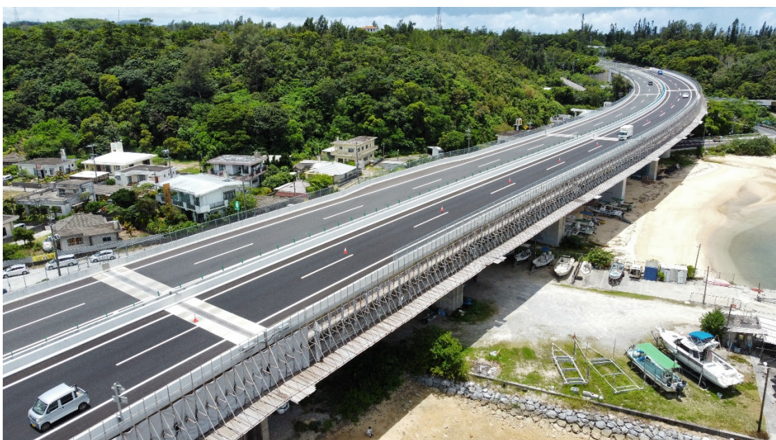
写真-2 許田高架橋全景
