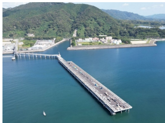
写真-4 床版据付完了
