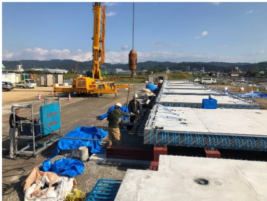
写真-1 ポストテンション緊張作業
