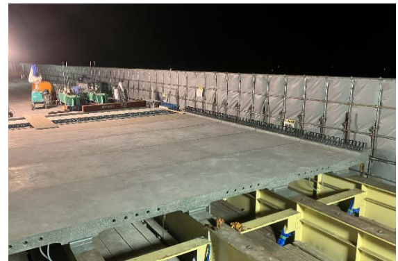
写真-1 床版設置後
