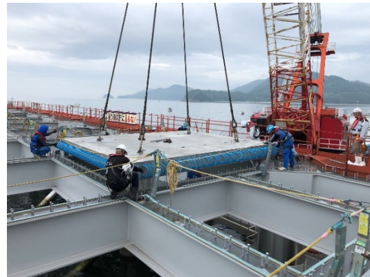
写真-2 床版据付状況
